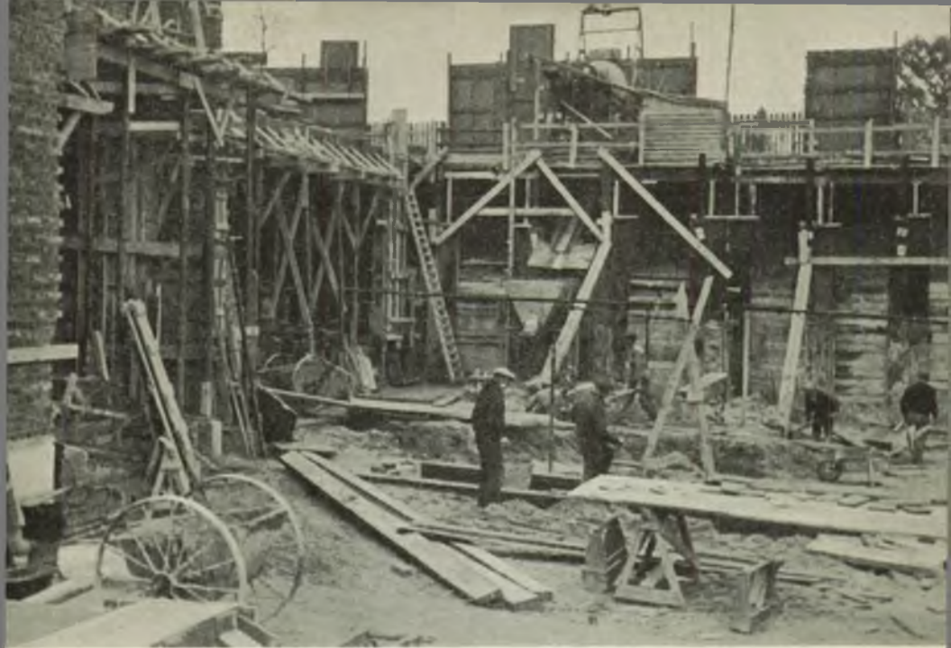
EEN HOEKJE OP HET BOUWTERREIN VAN HET N.I.R. — 23 NOVEMBER 1935.
